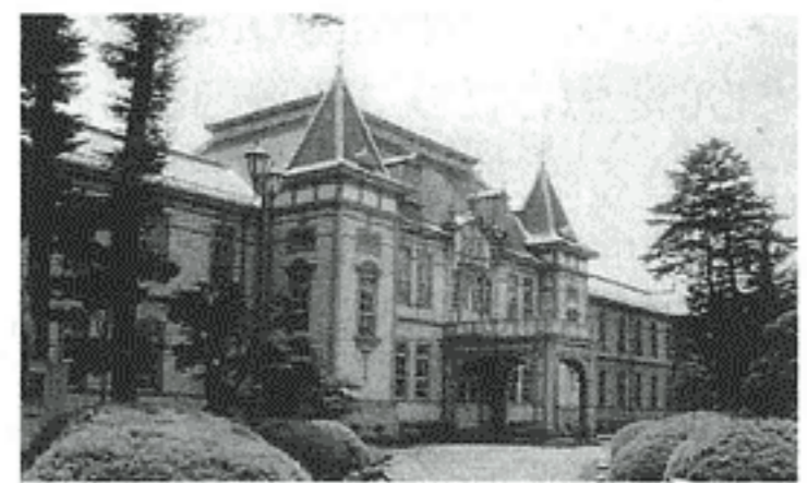
山形大学工学部内 米沢高等工業学校旧校舎(重要文化財)
